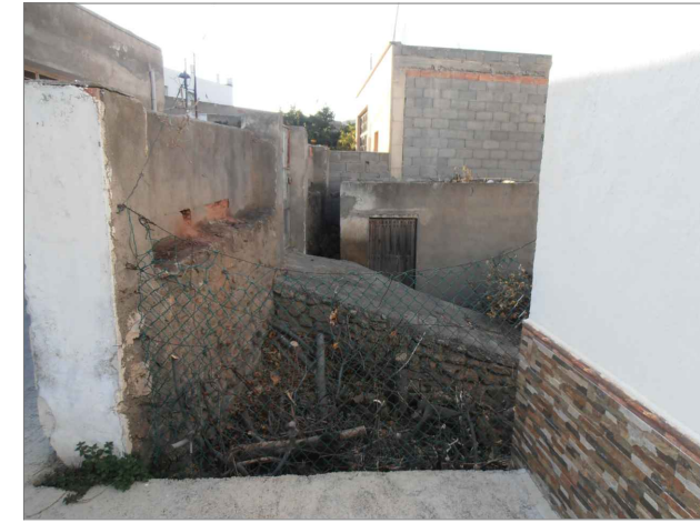
RAMPA DE ACCESO Y MURO DE CONTENCIÓN
